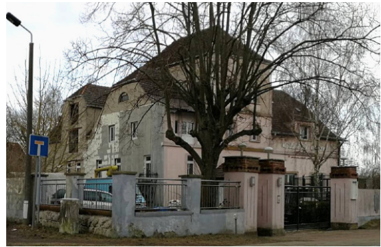
Gebäude mit erheblichem Sanierungsbedarf.
