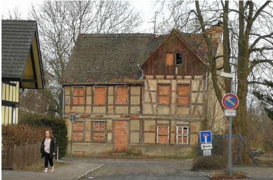
Leerstehendes und verfallenes Gebäude in der Bahnhofsallee.
