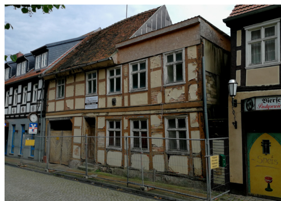
Leerstehendes, unsaniertes Gebäude.
