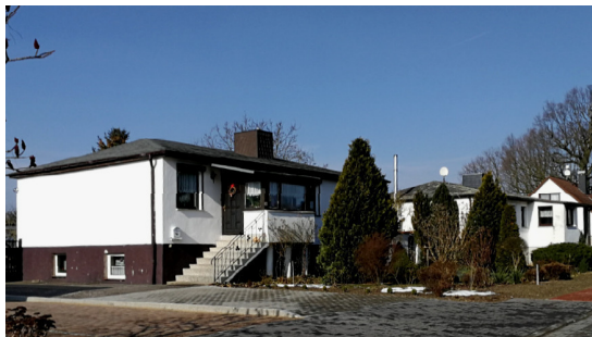
Einfamilienhäuser; Baujahr vor 1990.
