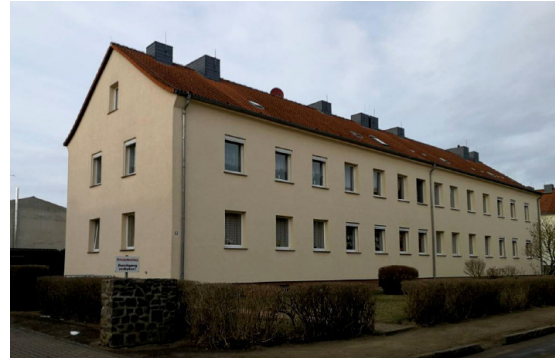
Saniertes Gebäude in der Ernst-Thälmann-Straße.
