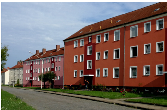
Gebäude in traditioneller Bauweise.
