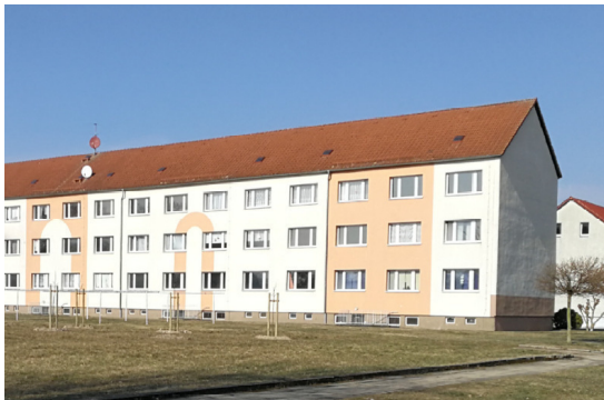
Gebäude in traditioneller Bauweise.
