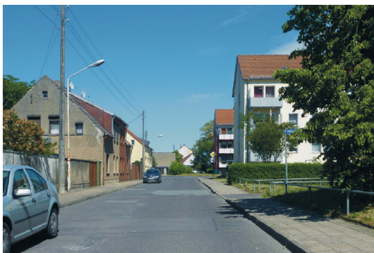
Im „Altneubaugebiet“ die Melker Straße vor dem Ausbau 2017.
