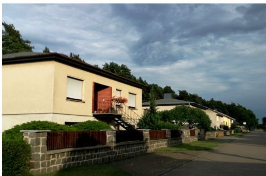
Einfamilienhäuser, Baujahr vor 1990
