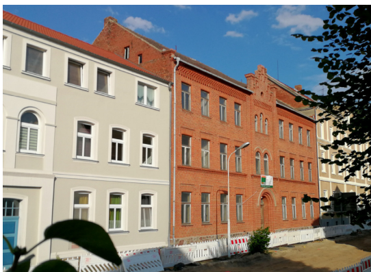
Leerstehendes, teilsaniertes Mehrfamilienhaus.
