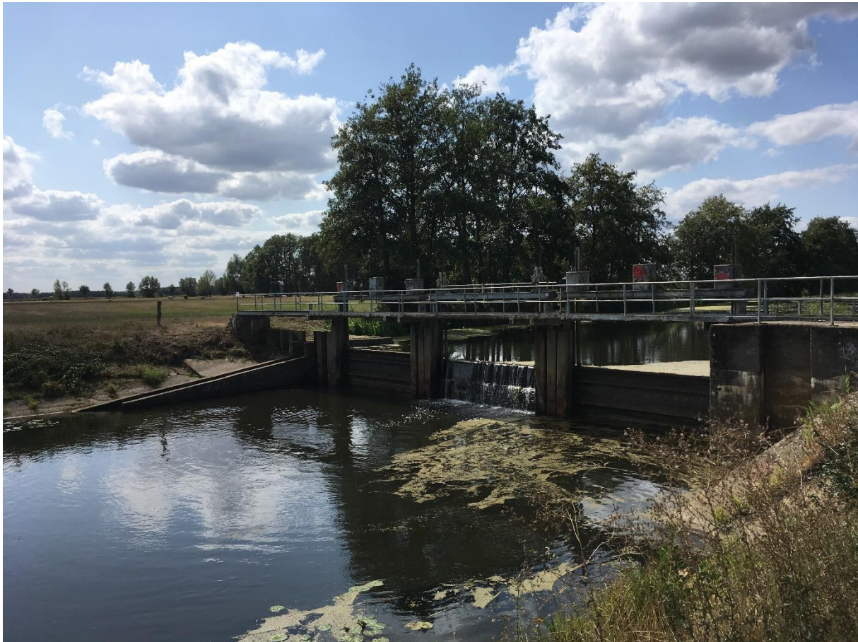
Abb. 7: Wehranlage an der Biese in Schliecksdorf
